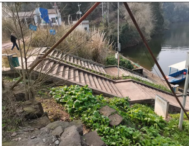
副坝上游坝坡面
