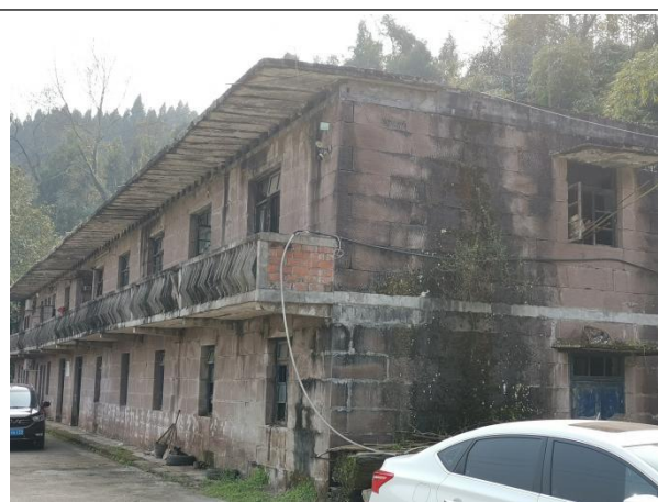
枢纽管理房侧面
