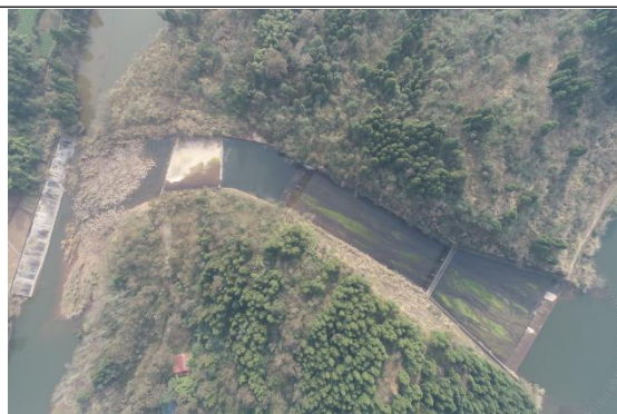
溢洪道俯视照片
