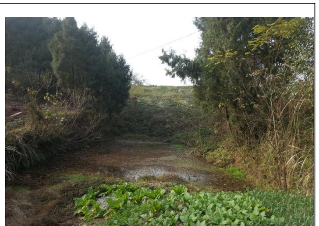
副坝下游渗水
