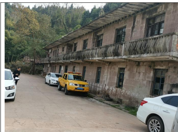
枢纽管理房正面
