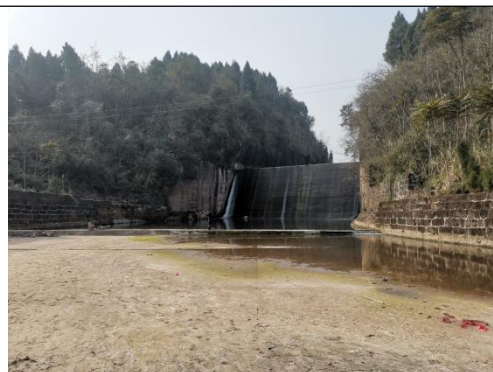
消力池及护坦两侧边墙
