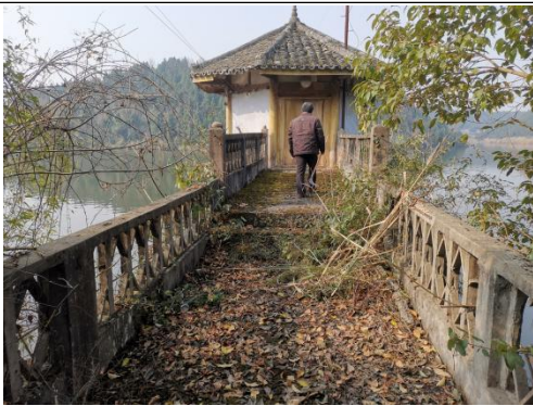
放空洞人行桥、启闭机房
